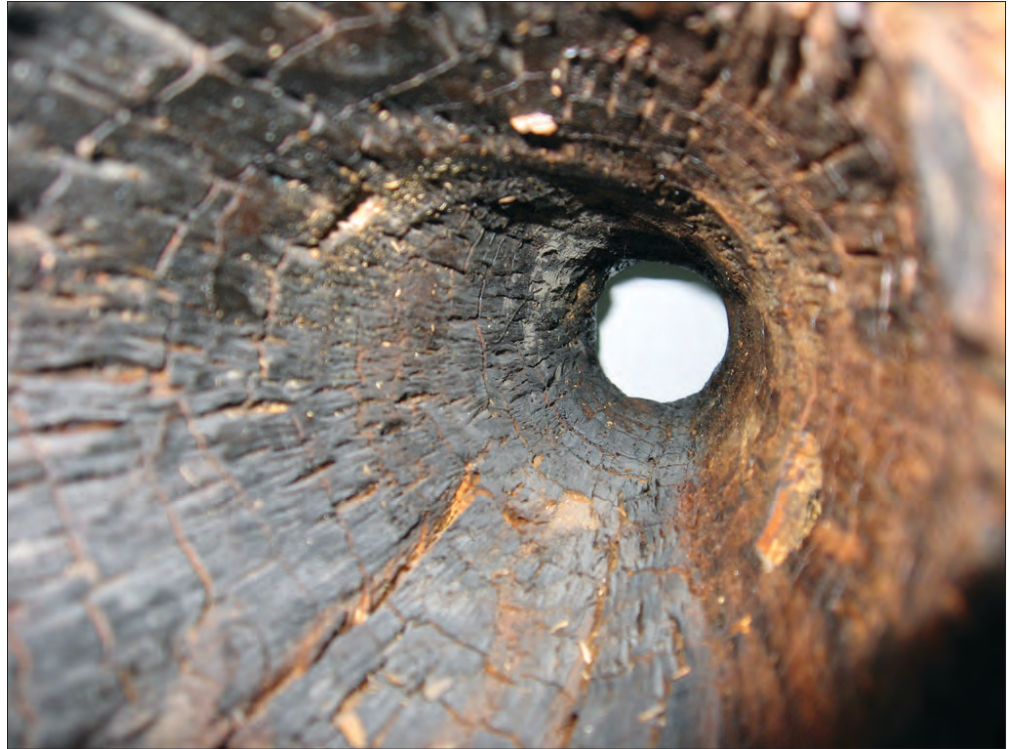
Slika 13.17 “Tomruci” unutrašnjost drvene vodovodne cijevi
