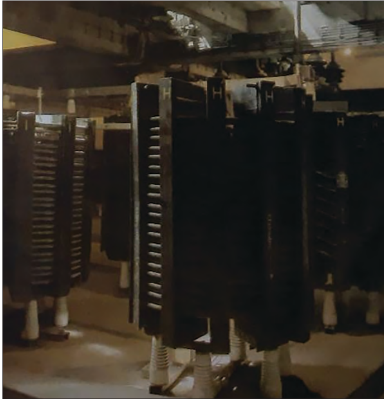
Slika 3.14 Energoinvestova laboratorija velike snage, d) prigušnice za podešenje struje kratkog spoja, 1985.
