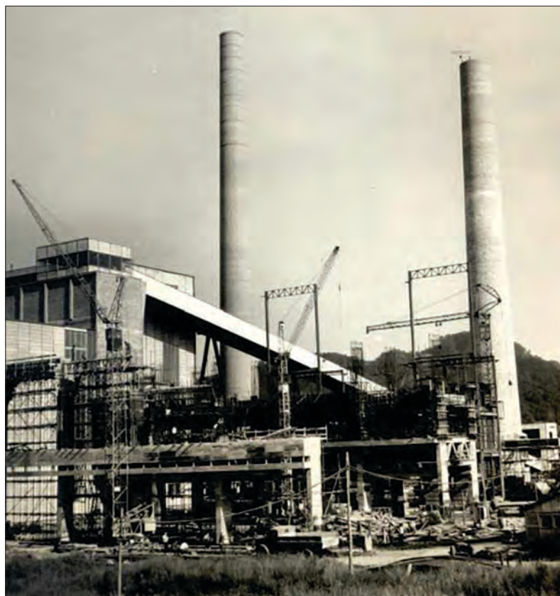
Slika 2.23 TE Tuzla, Izgradnja II etape, 1966.
