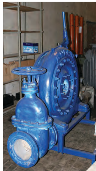
Slika 13.16 Turbinski krug (MHE Pršljenica/selo Vesela – Bugojno, proizvodnja 1937. godina)
